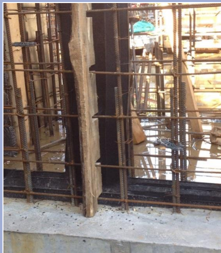
Волго-Балтийский канал, Волховский шлюз, гидроизоляция деформационного шва
