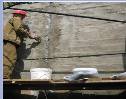
Волго-Балтийский канал, Волховский шлюз, гидроизоляция деформационного шва
