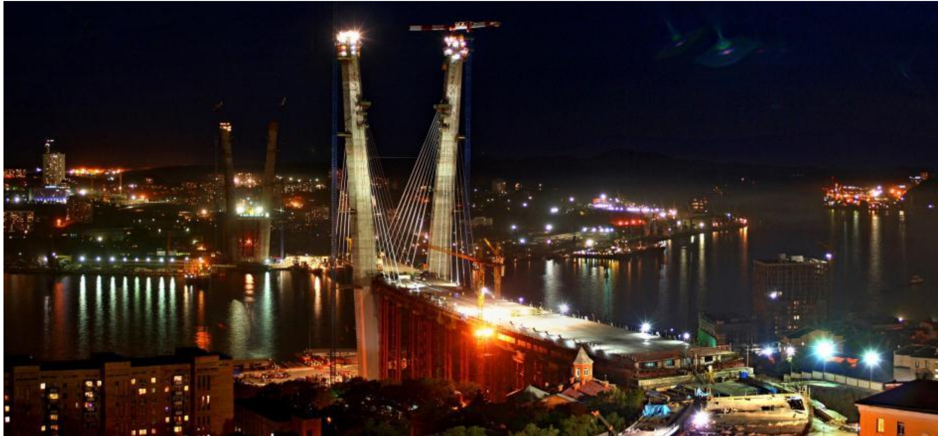
Вид на мост. Завершающий этап строительства пилонов
