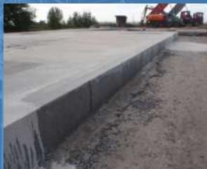
При строительстве взлетно-посадочной бетонной полосы аэродрома применялись составы бетона, обладающего повышенной прочностью на растяжение при изгибе **Btb4.0** и **Btb4.8**. Составы разработаны специалистами компании с использованием добавок специальных модификаций **ГПМ-ж 3/1** и **ГПМ-ж в. в.**
