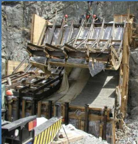
Разработаны технологии и составы кавитационностойких бетонов для подачи бетононасосом в конструкции берегового водосброса с применением добавки **ЦМИД-4** и обеспечением высокой гладкости поверхности бетона.
