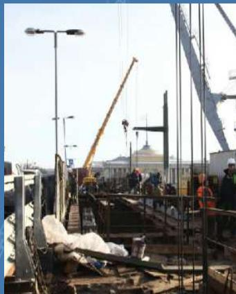
Специалистами компании ЗАО «НП ЦМИД» была разработана технология ремонта ниш (котлованов) под противовесы разводного механизма моста.
