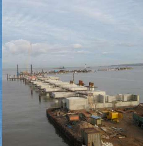
В целях дноукрепления использовался неразмываемый бетон для подводных работ с применением добавки **ЦМИД-4П**.
